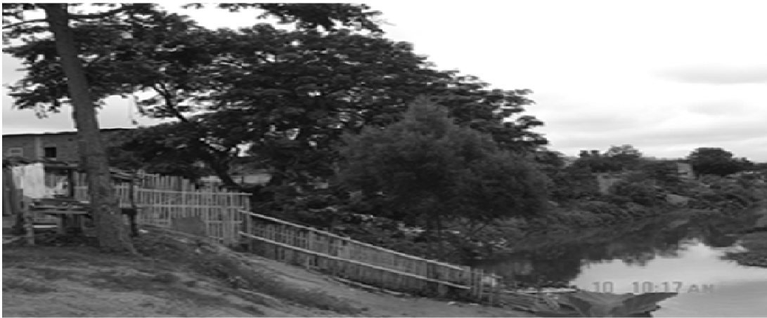
Figura 3. Viviendas que invaden la margen de río Portoviejo
