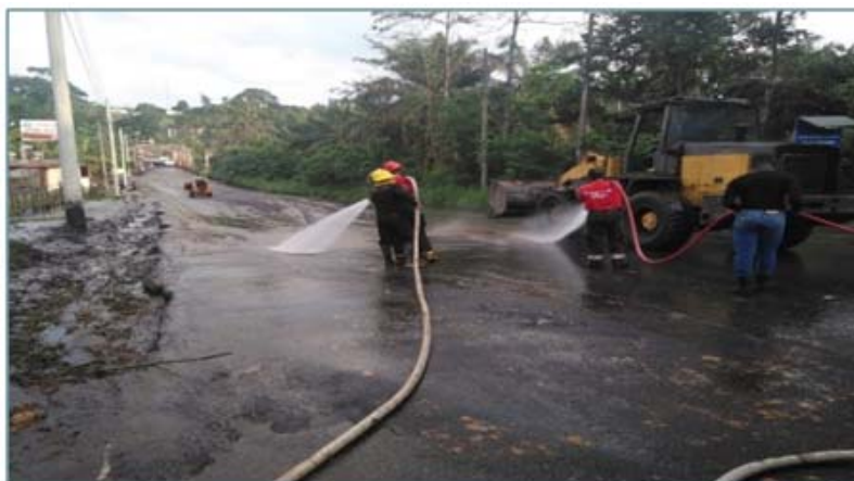
Figura 2. Lavado de vías afectadas con ayuda del cuerpo de bomberos del cantón Imagen Tomada: por el departamento de ambiente del GAD de Quinindé
