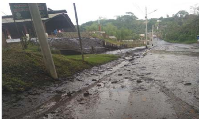
Figura 6. Lodo derramado en la vía
